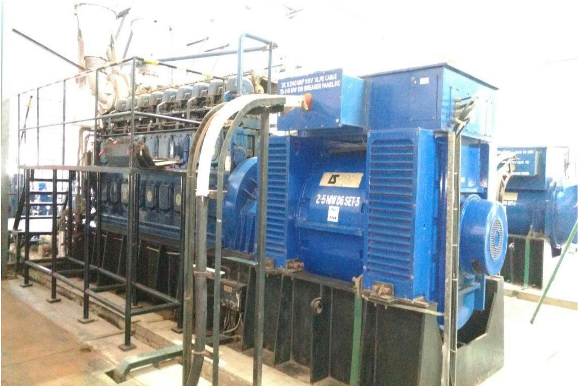
***Diesel Generator Set 4 – 2.5 MW***
